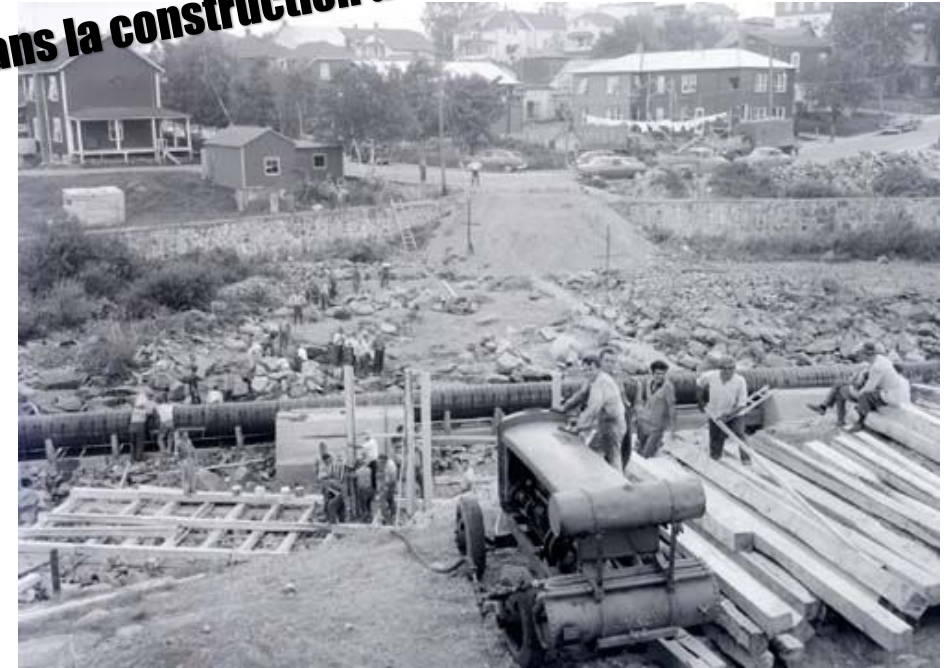
Construction du pont Tranquille, Alma, 10 septembre 1959.
