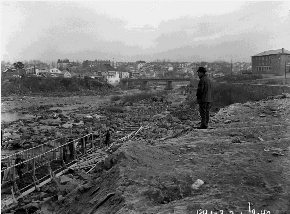
Construction d'égout collecteur, Alma, 1962.
