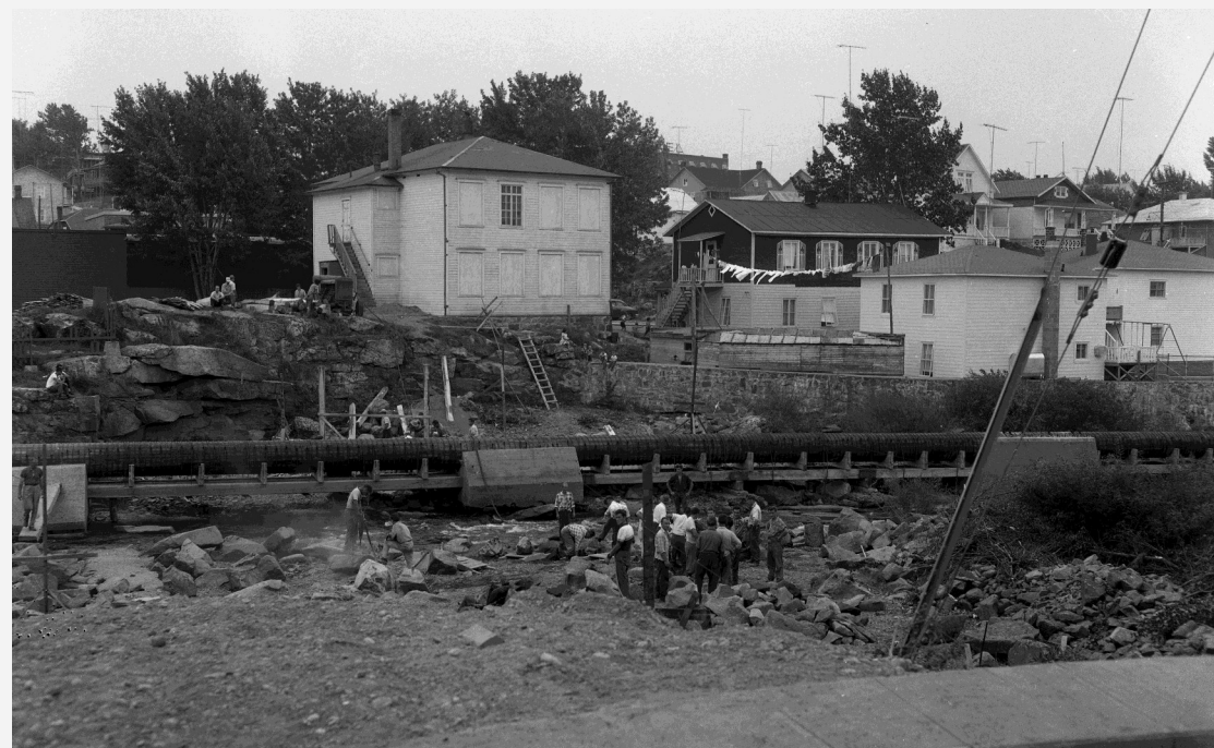
Construction du pont Tranquille, Alma, 1959.
