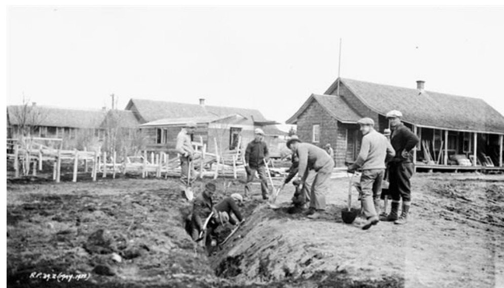
Des hommes construisant une route au camps de travail de Valcartier, mai 1933. Source : Bibliothèque et Archives Canada
